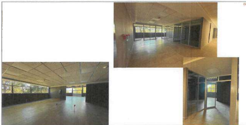
FOTOGRAFIA 3 (F3). 1er. Nivel. Conclusión de instalación eléctrica, voz y datos.
