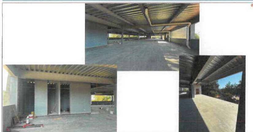
FOTOGRAFIA 1 (F1). 2do nivel, (convenio ampliación). Albañilería muros castillos y cadenas perimetrales y de módulos sanitarios, aplanados y pintura; e inicio colocación de piso de loseta.
