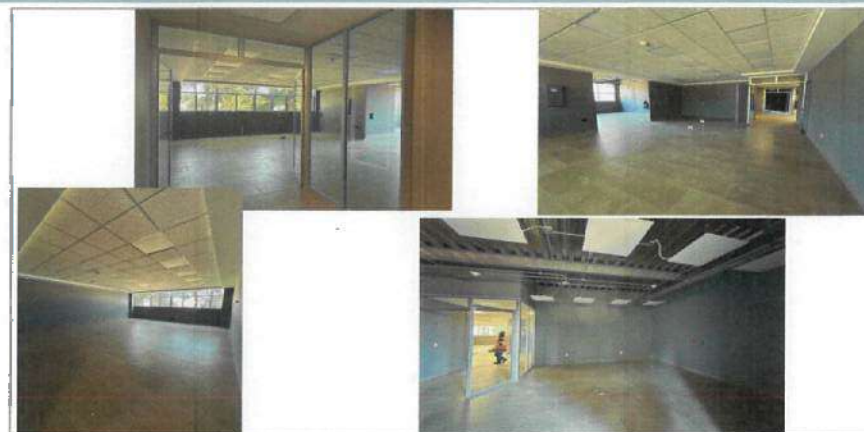
FOTOGRAFIA 2 (F2). 1er Nivel Conclusión de trabajos de acabados: pintura, cancelería, plafones, instalaciones; y limpieza
