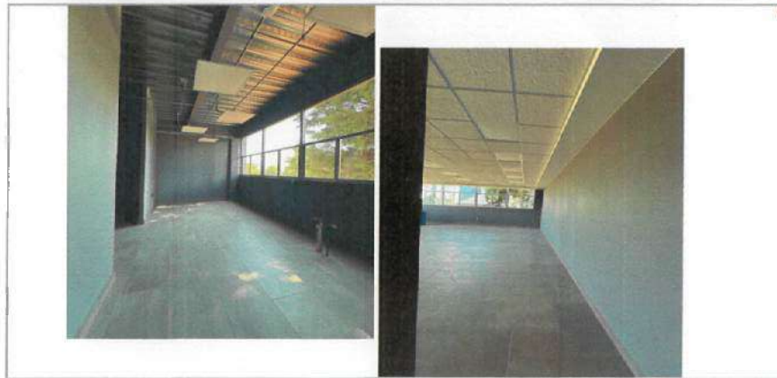
FOTOGRAFIA 4 (F4). 1er. Nivel. Conclusión de trabajos de acabados: aplanados en muros interiores y pintura.
